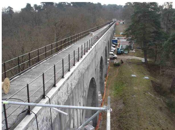
Das Aquedukt in der Nähe von Paris ist eine wichtige Zubringerleitung für die Wasserversorgung der Hauptstadt. Das Bauwerk ist 470 m lang und hat einen Innendurchmesser von 2 m und wurde mit AGRU Betonschutzplatten 8 mm ausgekleidet.
