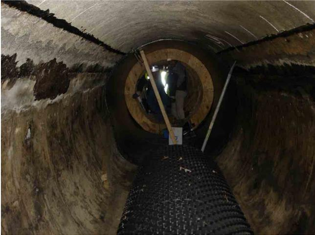
Für die Verlegung wurden die vorgefertigten Betonschutzplatten im zusammengerollten Zustand in den Tunnel eingebracht. Nach dem lösen der Transportbänder wurde die AGRU Sure Grip Platte mit einer Holzschalung fixiert und der Zwischenraum zum bestehenden Beton mittels Injektionsmörtel verfüllt. Dadurch wird optimale Verankerung der Platten erreicht.
