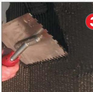
**3** Оба компонента **COMBIFLEX®-KMB** перемешать до однородного состояния и в зависимости от степени нагрузки нанести в один или два слоя. Для достижения равномерной толщины слоя КМВ прочесать зубчатым шпателем и затем выровнять.
