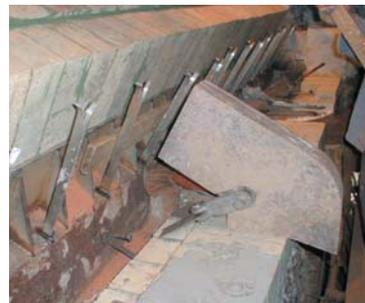
Die Spezialformsteine in 10 %igem Chromkorundwerkstoff werden durch Gussanker gehalten.
