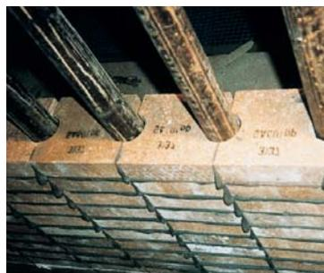
Zustellung einer wassergekühlten Rohrwand mit speziellen Formsteinpositionen, die ein schnelles Auswechseln ermöglichen.
