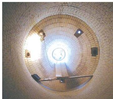
Längere Standzeiten durch hochverschleißfeste Werkstoffe, hier als liegende Brennkammerauskleidung in einem Thermal Oxidiser.
