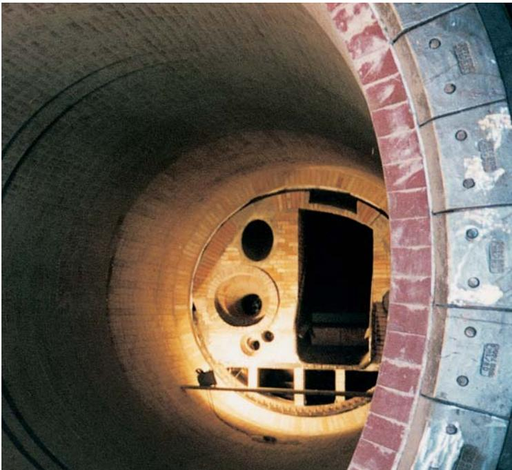
Blick in einen mit Chromkorundsteinen „Suprema CZK 855 P“ ausgekleideten Drehrohrofen, in dem Sonderabfälle bei Temperaturen zwischen 1200 und 1400 °C verbrannt werden. Die Ziellaufzeit beträgt ca. 18 Monate.
